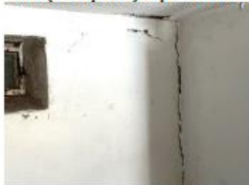
Garáž (bez súp. čísla) na parc. KN č. 2084/17 - pohľady na vertikálnu trhlinu v rohu garáže, garážové vráta a krov
