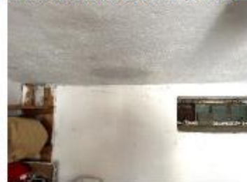
Garáž (bez súp. čísla) na parc. KN č. 2084/17 - pohľady na vnútorný priestor, lokálne zavlhnutie omietky na podbití krovu
