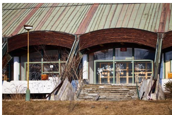
Športová hala - Korytnačka
