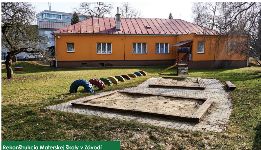
Rekonštrukcia Materskej školy v Závodí
